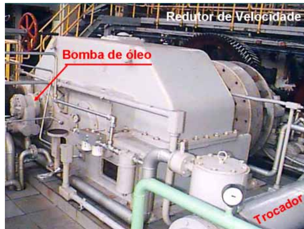
Figura 14.3.1 - Redutor de Velocidade
