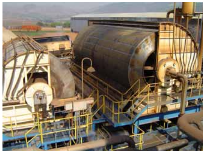
Figura 15.4.1 – Filtro Rotativo
