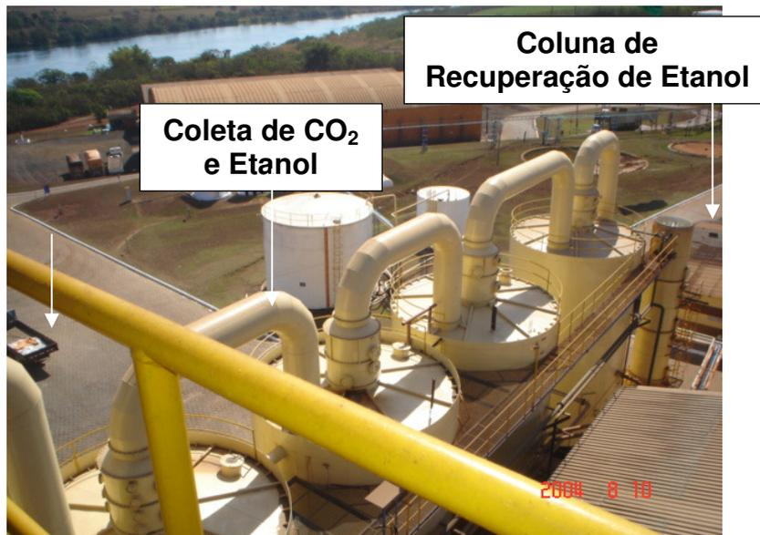
**Figura 3.3.10 (a) – Dornas Contínuas com Sistema para Recuperação de Etanol**
