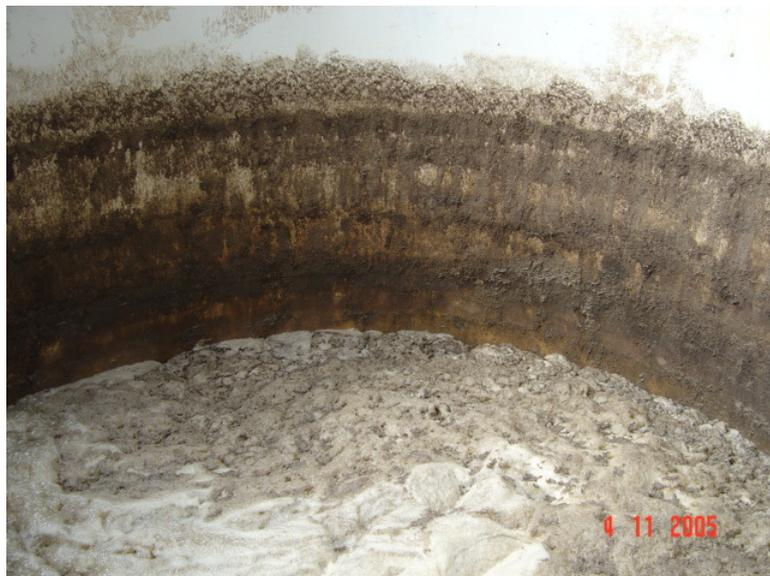
**Figura 4.3.1 (b) - Formação de biofilme torna-se um foco crítico e constante de contaminação**
