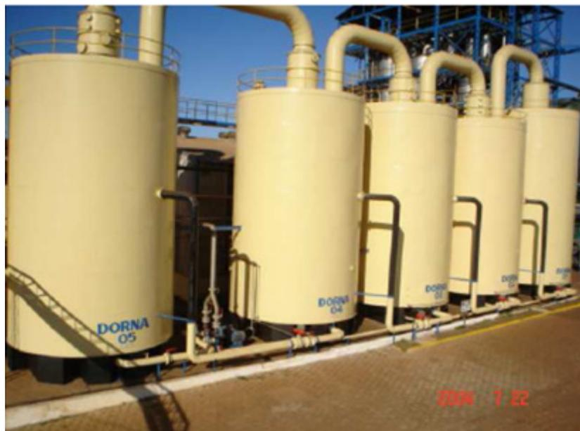
**Figura 4.3.4 (c) – Biorreatores (Dornas) da Usina Alvorada**
